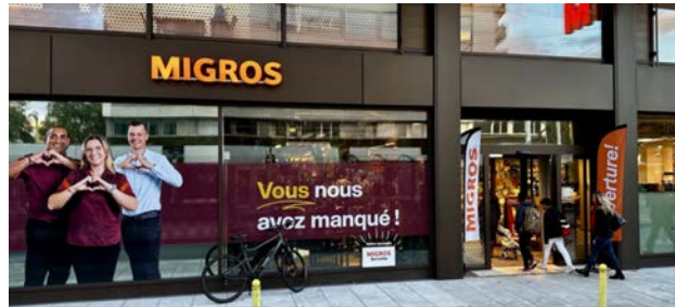
Migros Servette, un chantier imposant qui a duré plus de 2 ans.
