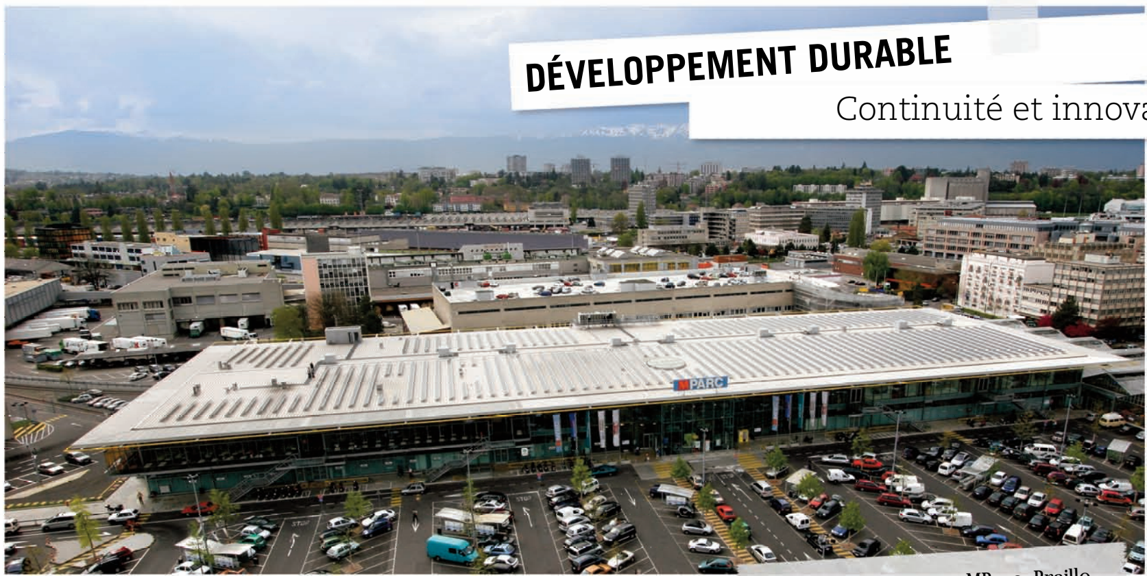
Energie solaire au MParc Praille
